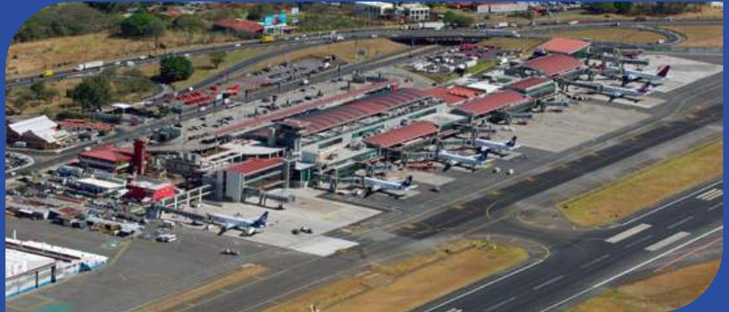
El AIJS tiene una pista de aterrizaje denominada 07/25, orientada hacia el noreste/suroeste y que mide 3 011m de longitud por 45m de ancho. Asimismo, el aeropuerto está provisto con un conjunto de calles de rodaje para el movimiento de aeronaves, a ambos costados de la pista (sur/norte). Estas dimensiones permiten a las aeronaves operar de forma segura.
